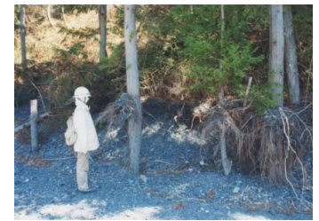
井川演習林。砂防ダムができ、河床が上昇し、川幅が広がり、側岸の林が侵食される。
